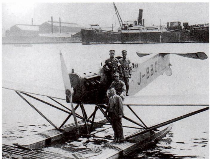
↑ 乗務員の訓練用として使われていたドイツ製の水上機。
