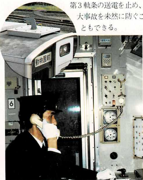
▲運転指令所と交信できる列車無線と車両アンテナ
