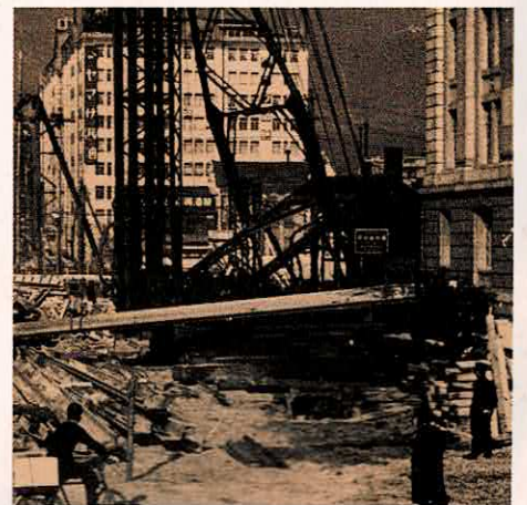
▲鋼矢板の打込作業
