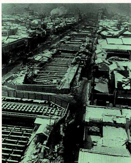
▲御堂筋での建設工事
