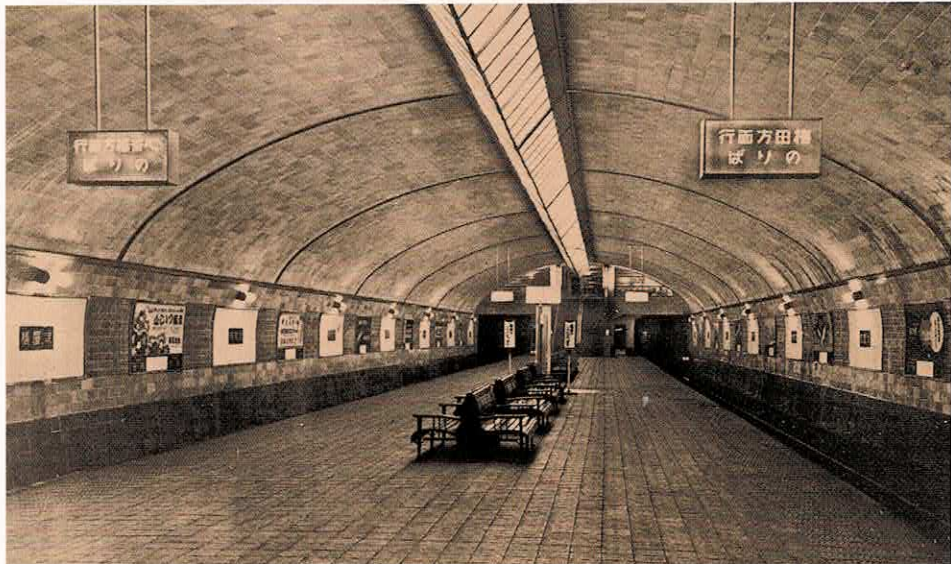
▲宮殿のような淀屋橋駅ホーム、側壁は水色で仕上げる
