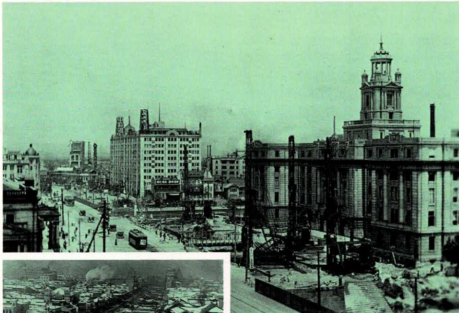
▲市役所前の建設工事
