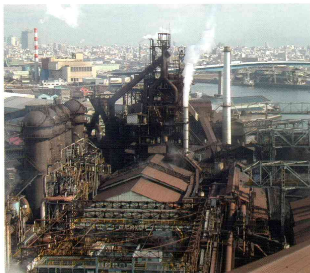
改修が完了した第2高炉全景
