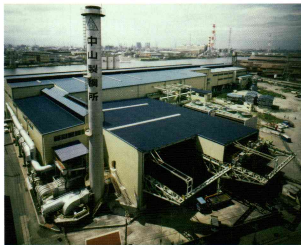
新形鋼工場の全景
