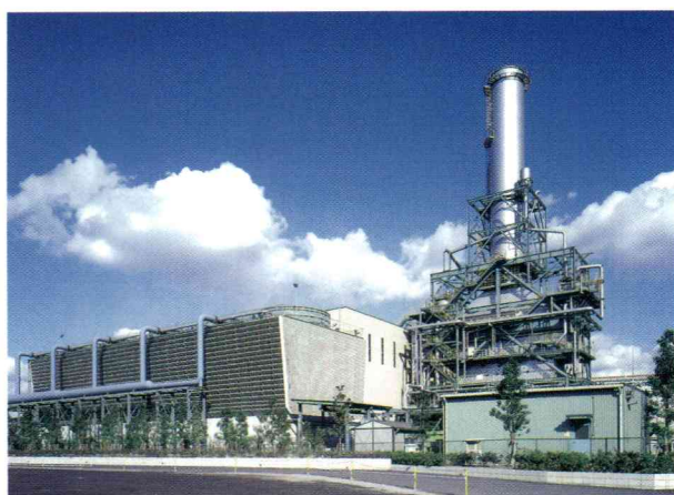
中山共同発電プラント外観
