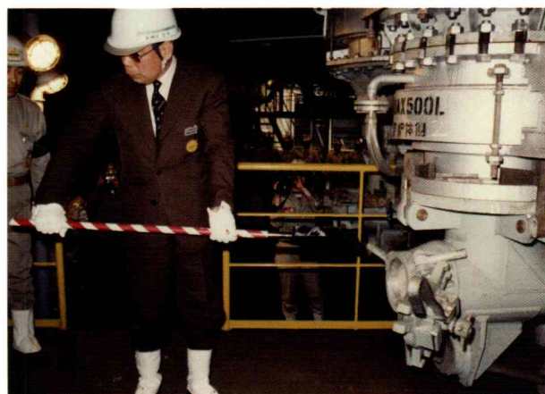
角谷社長による第6次第2高炉火入れ式
