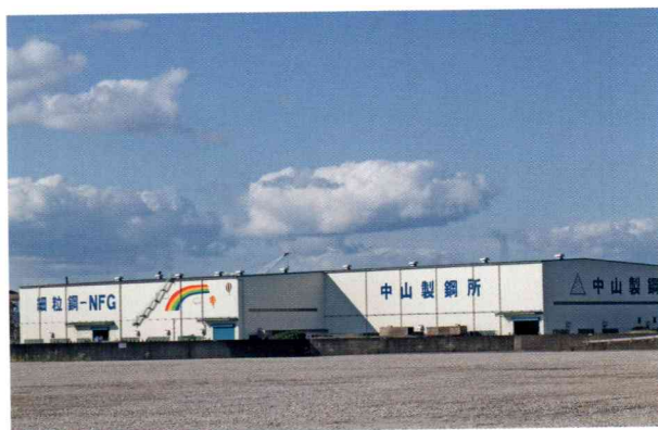
完成した第一製品倉庫
