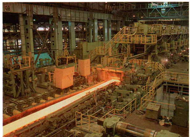
稼働を開始した熱延工場
