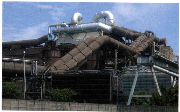
改造した電気炉工場建屋
